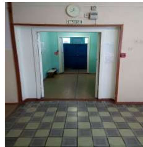
Фото №7 Путь эвакуации
