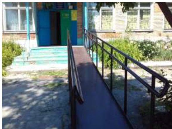
Фото №2 Пандус, входная площадка, дверь входная
