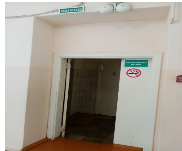
Фото №6 Пути эвакуации
