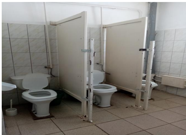
Фото №8 Туалетная комната
