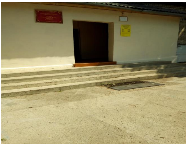
Фото №2 Входная площадка перед дверью, крыльцо
