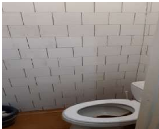
Фото №8 Туалетная комната
