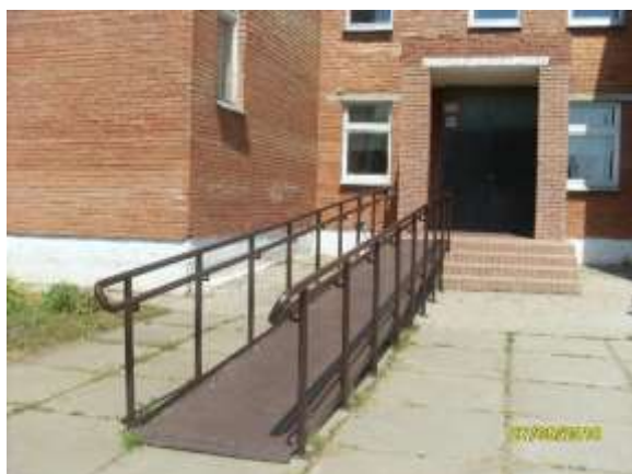
Фото №2 Пандус, входная площадка, входная дверь
